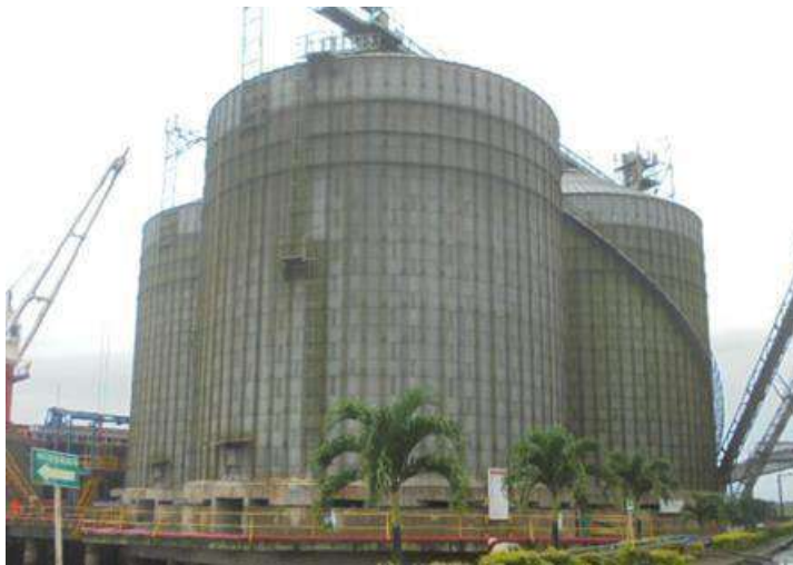
Imagen 20 Silos Verticales 1 al 4 de COMPAS IP- Buenaventura
