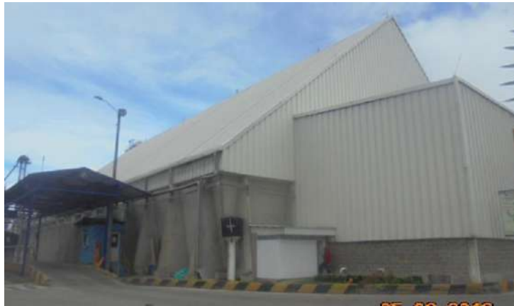
Imagen 19. Bodega granelera 5 Terminal COMPAS IP- BUENAVENTURA
